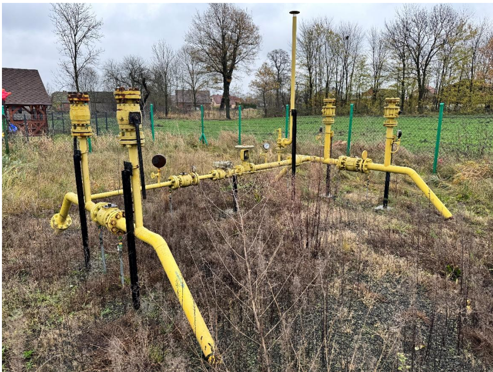
Zdjęcie nr 2 – układy rurowe zewnętrzne stacji gazowej (ZZU wlotowy, układ awaryjny, ZZU wylotowy)
